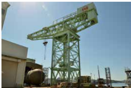
佐世保重工業(株)佐世保造船所250トンの起重機 (大正2年、立神町) イギリスのサー・ウィリアム・アロル社に発注されたジャイアント・カンチレバー・クレーン。日本に3台、世界にも11台しか残っていません
