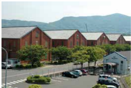
米海軍佐世保基地メインベース地区 (旧佐世保軍需部倉庫群、明治21～昭和11年、平瀬町) 明治37年までに11棟が建設され、主に食品や衣料品を保管しました。大正から昭和にかけて増築されています
