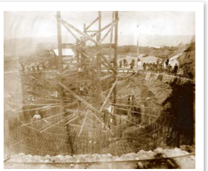
針尾無線塔配筋工事の様子
