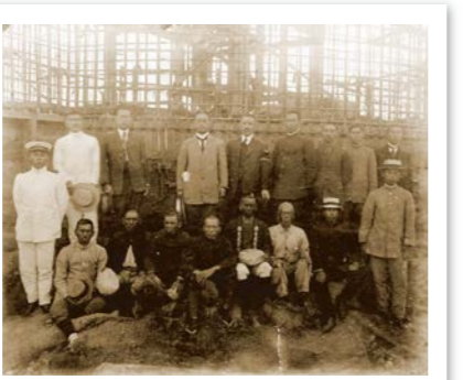
針尾無線塔の工事関係者
