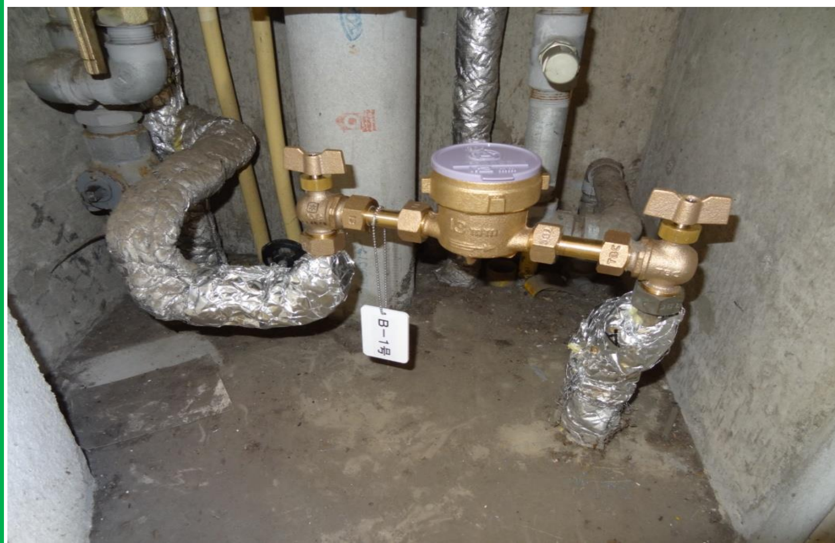
アングル型伸縮式ボール止水栓組み合わせ施工例
