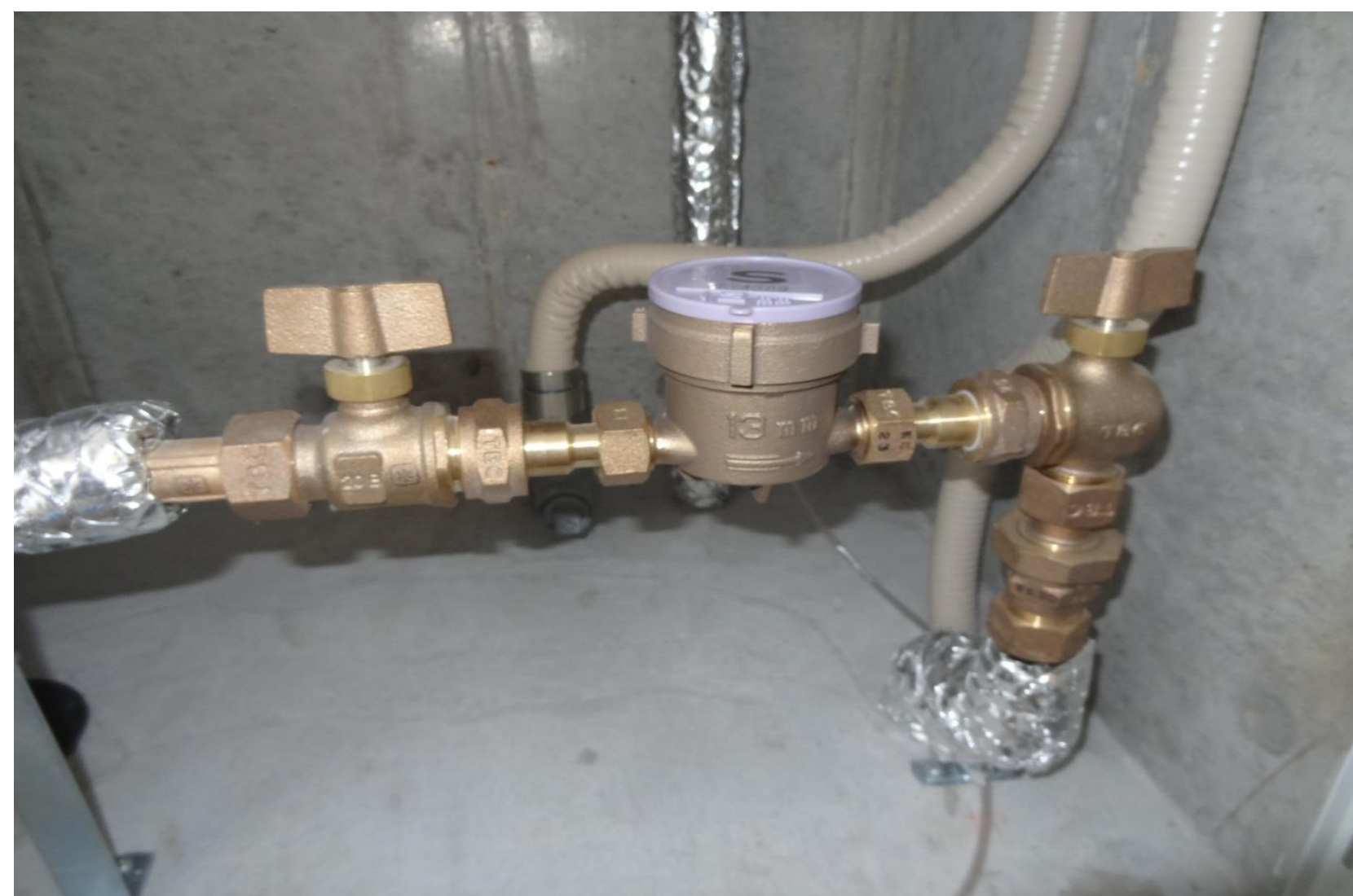
アングル型伸縮式ボール止水栓組み合わせ施工例
