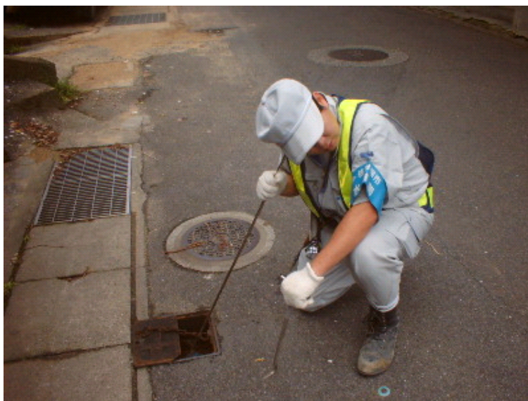
図 7.13 漏水状況及び漏水調査
