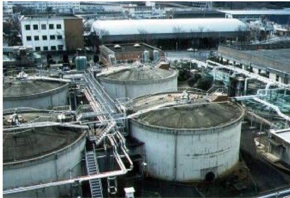
図 8.16 汚泥消化槽（中部下水処理場）
