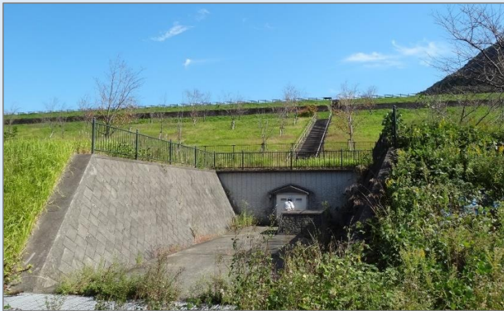
本市最古のダム。平成18年に堤体補強を実施。
