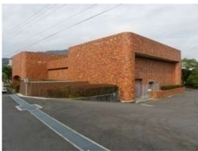
平瀬ポンプ場
