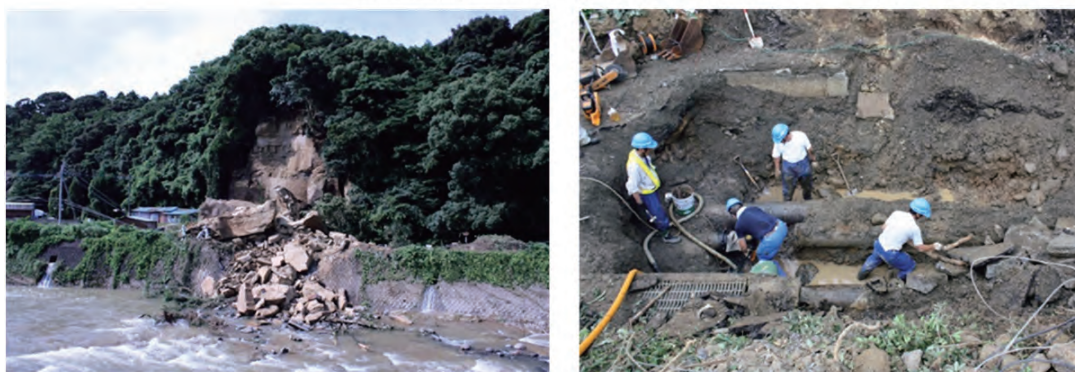
H21瀬戸越崩落事故の様子
