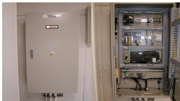
【北部地区遠方監視装置整備（その3）工事】
