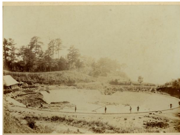
第 2 貯水池建設の様子（明治 33 年ごろ）
