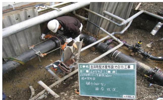
【吉井町配水管布設（その15）工事】
