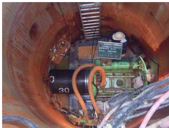
【推進工法による工事】
