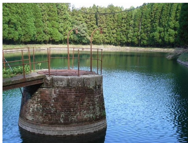
第 1 貯水池取水塔
