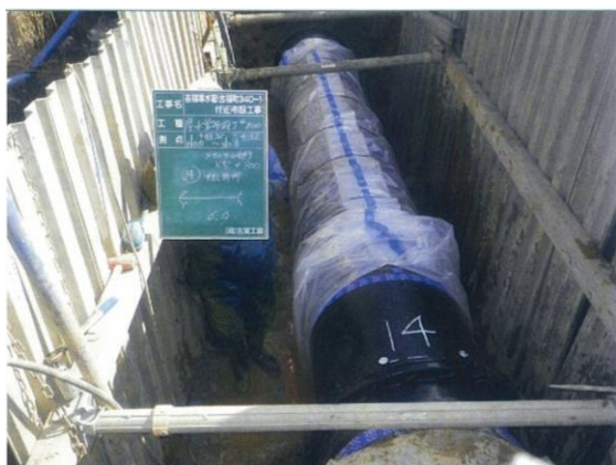
【吉福導水管布設工事】
