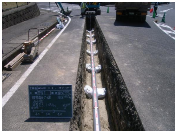
【開削工法による工事】
