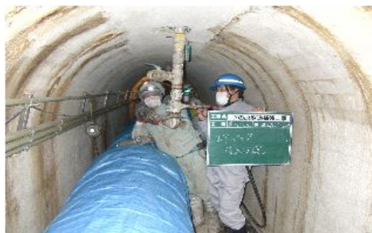
【下の原隧道補強工事】
