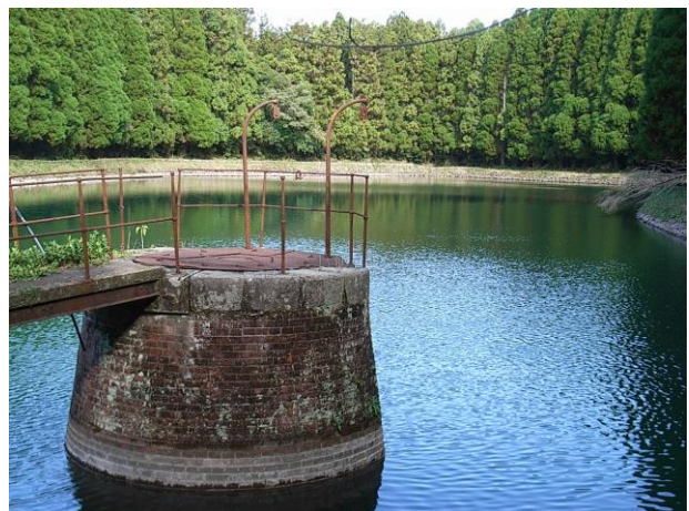
第 1 貯水池取水塔
