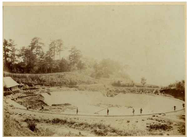
第 2 貯水池建設の様子（明治 33 年ごろ）
