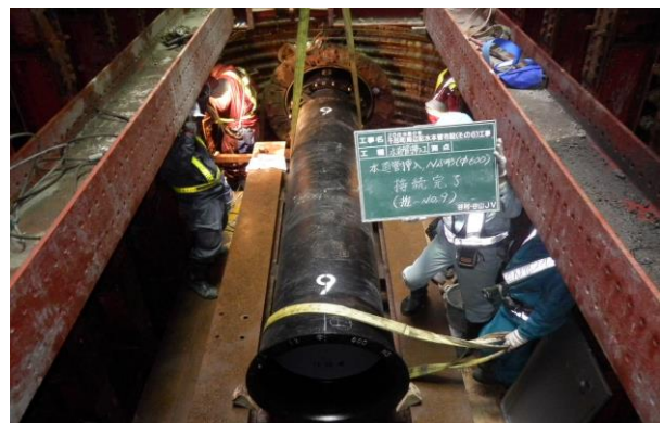
【干尽町周辺配水本管布設（その6）工事】
