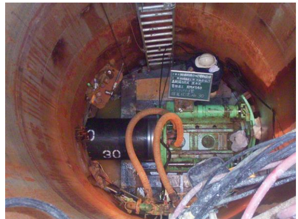
【推進工法による工事】
