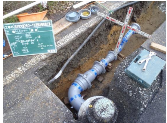
【吉井町配水管布設工事】
