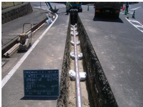
【開削工法による工事】
