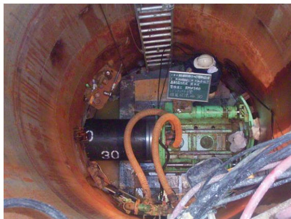
【推進工法による工事】
