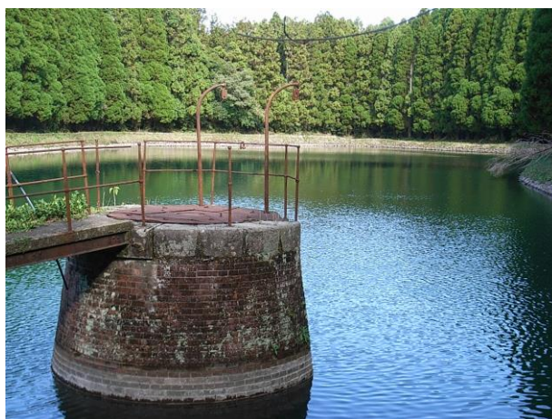
第 1 貯水池取水塔
