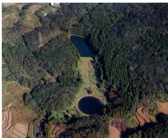
岡本水源地全景
