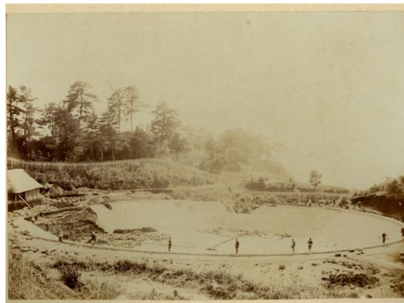
第 2 貯水池建設の様子（明治 33 年ごろ）
