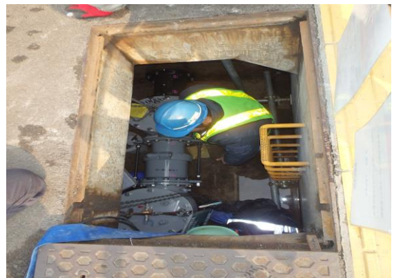
【権常寺1丁目6-3付近減圧弁設置工事】
