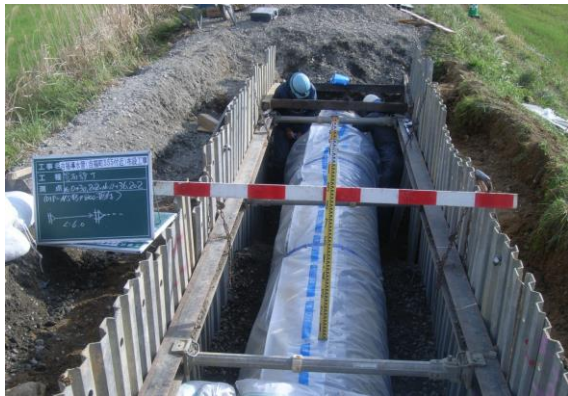
【吉福導水管布設工事】
