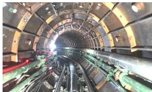
【一次覆工が完了した坑内】
