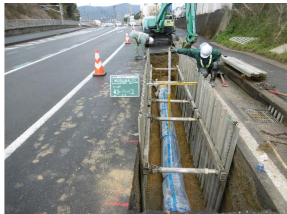
【崎岡町 3 1 5 1 付近配水布設工事】
