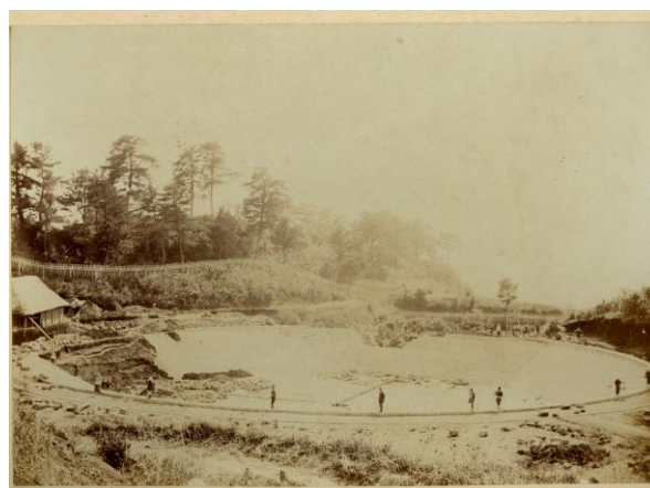
第2貯水池建設の様子（明治33年ごろ）
