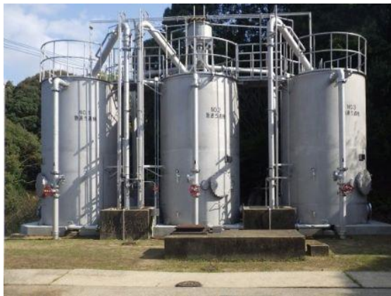
【江迎浄水場ろ過機更新工事】
