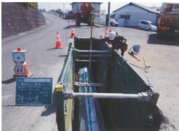
【菰田導水管（野中町 3 7 6 付近）布設工事】
