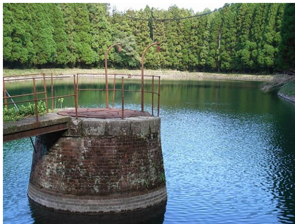
第1貯水池取水塔
