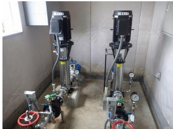
【柚木元町第一ポンプ所更新工事】
