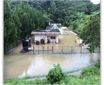
《歌ヶ浦浄水場》
