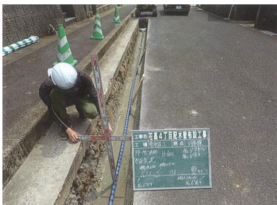
【花高4丁目配水管布設工事】
