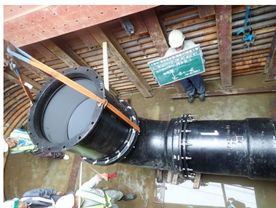
【菰田導水管（地蔵川）推進工事】
