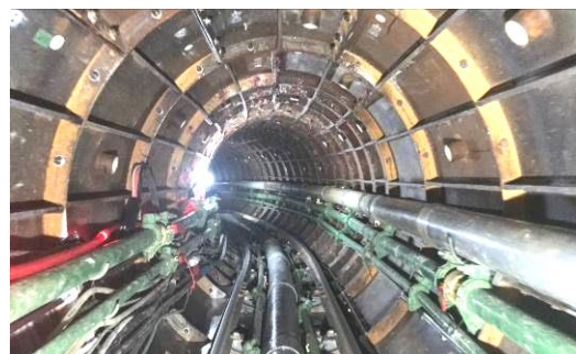
【一次覆工が完了した坑内】
