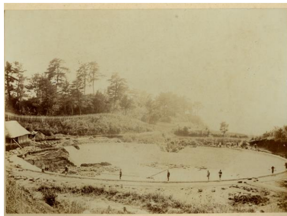
第2貯水池建設の様子（明治33年ごろ）
