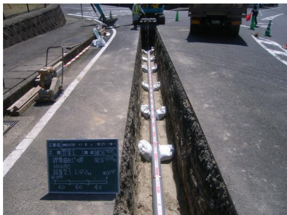
【開削工法による工事】
