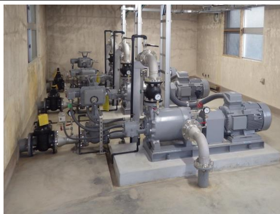
【東山手ポンプ所設備更新工事】
