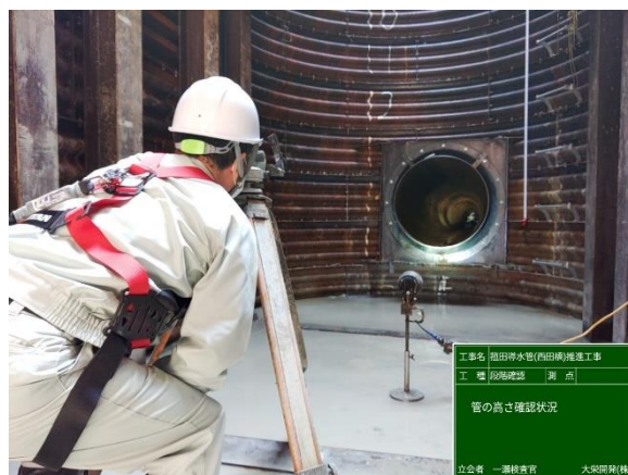
【菰田導水管（西田橋）推進工事】
