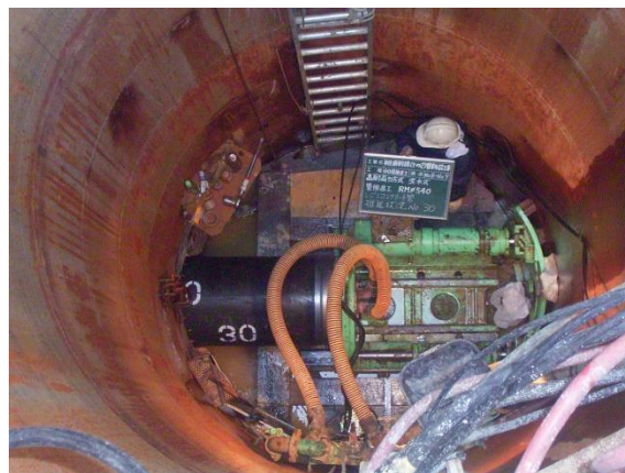
【推進工法による工事】
