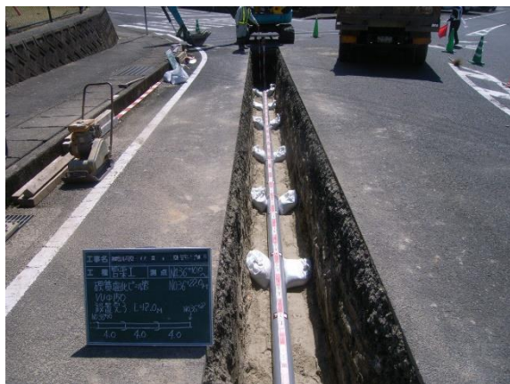
【開削工法による工事】
