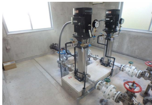
【高花ポンプ所設備更新工事】
