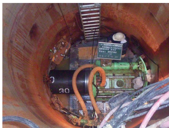
【推進工法による工事】
