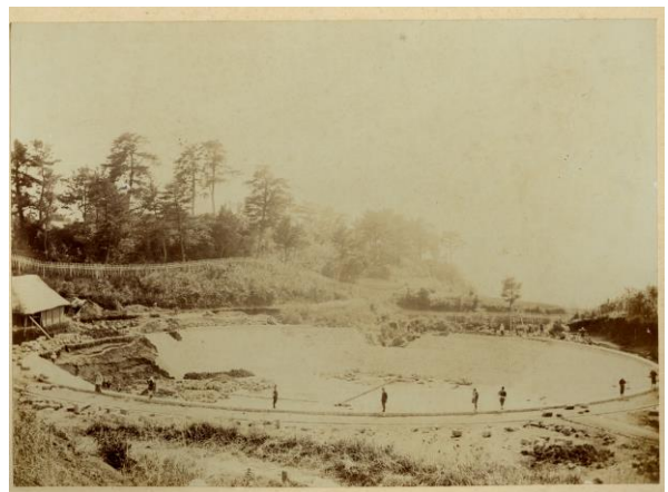
第2貯水池建設の様子(明治33年ごろ)
