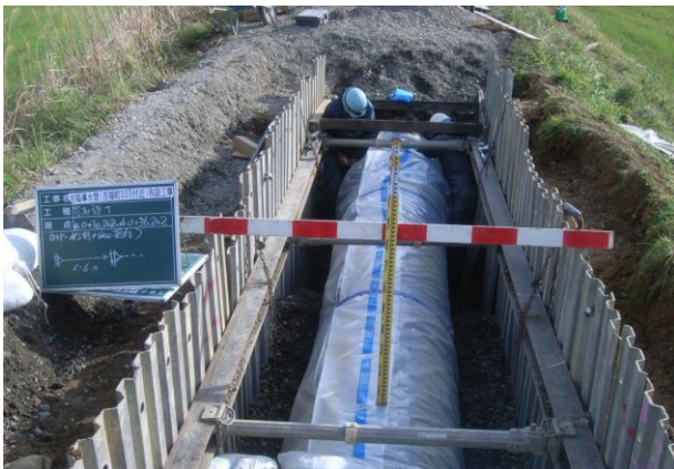
【菰田導水管布設工事】
