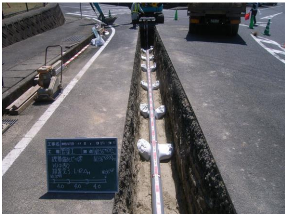
【開削工法による工事】
