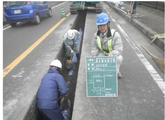
【指方町 3438 付近配水管布設工事】
