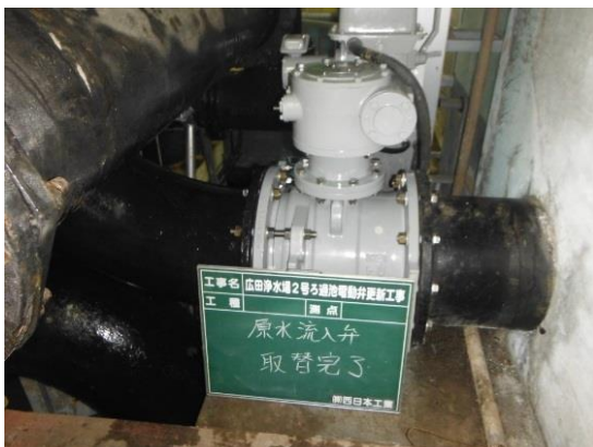
【広田浄水場ろ過池電動弁更新工事】
