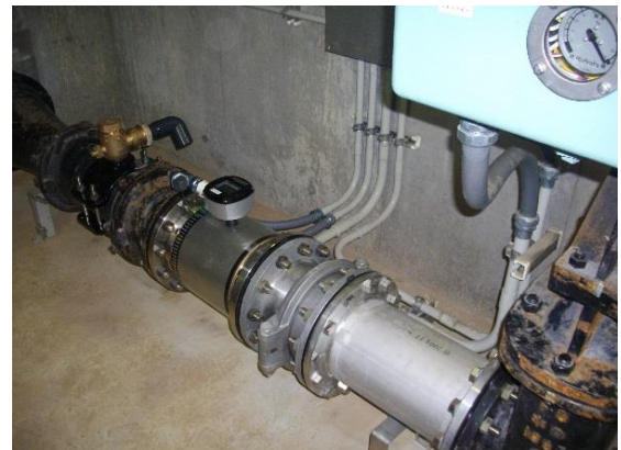
【折橋配水池ほか流量計更新工事】
