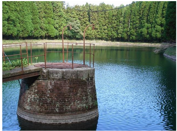
第1貯水池取水塔
