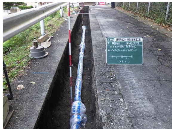
【長坂町 641 付近配水布設工事】
