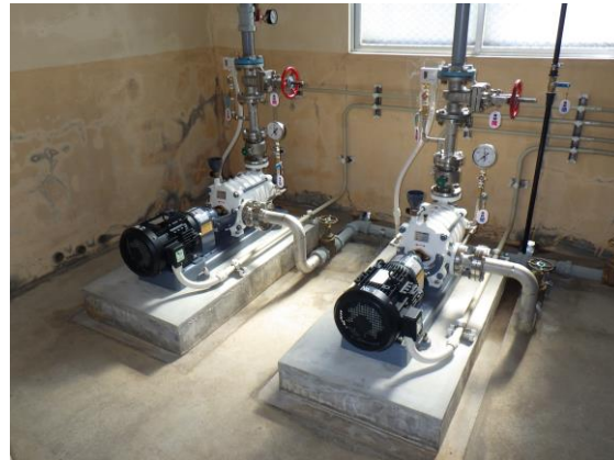
【黒髪団地ポンプ所更新工事】
