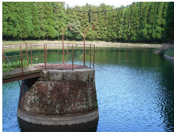
第1貯水池取水塔
