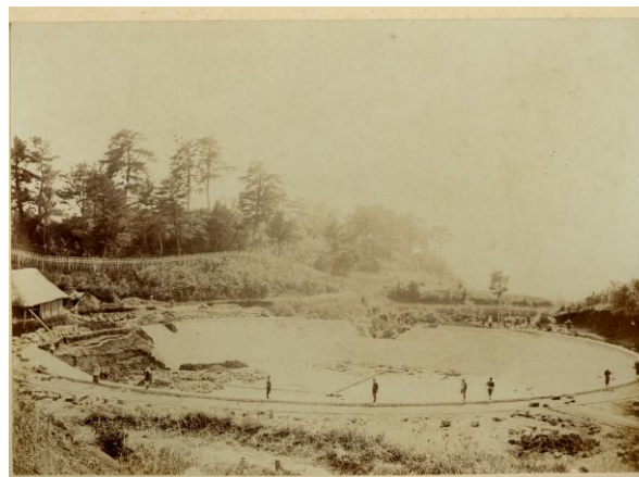
第2貯水池建設の様子（明治33年ごろ）
