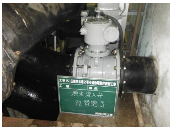
【広田浄水場ろ過池電動弁更新工事】
