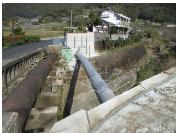
【菰田導水管（大原橋）水道橋更新工事】
