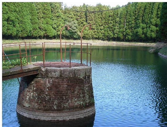
第 1 貯水池取水塔
