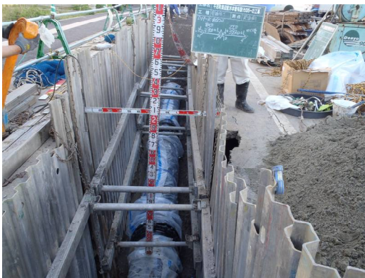
【干尽町周辺配水本管布設（その5-2）工事】
