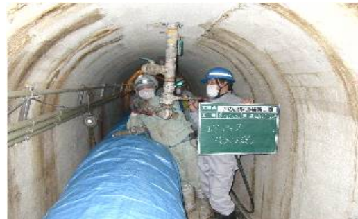
【下の原隧道補強工事】
