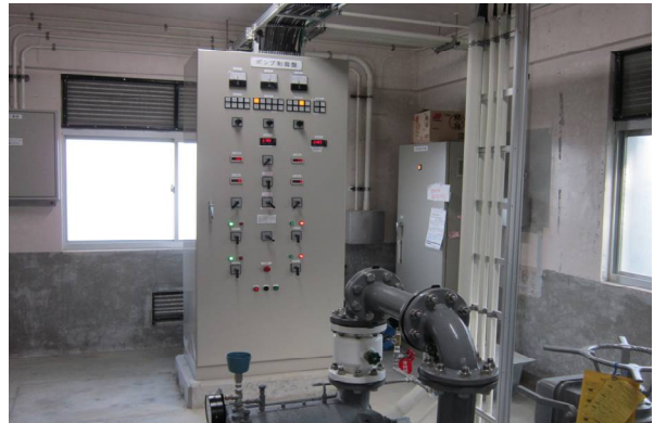
【吉岡ポンプ所更新工事】
