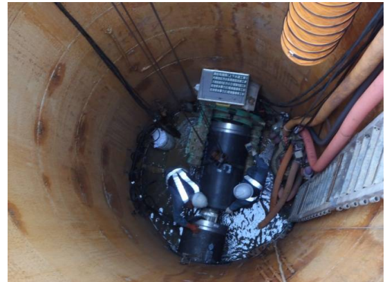
【推進工法による工事】
