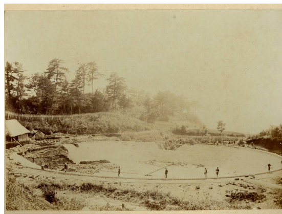
第 2 貯水池建設の様子（明治 33 年ごろ）
