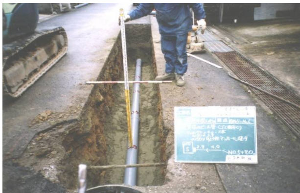
【開削工法による工事】
