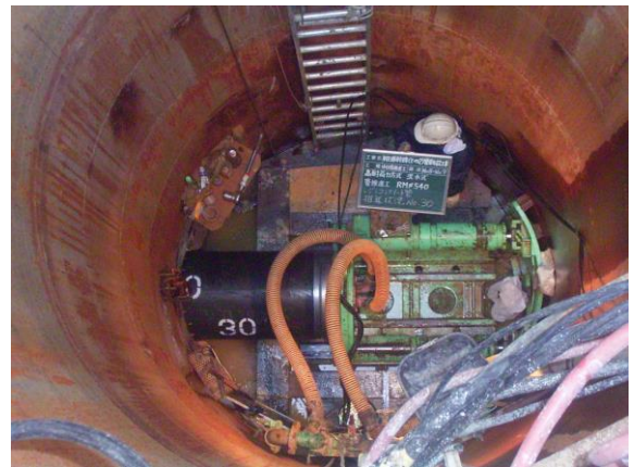
【推進工法による工事】
