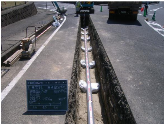
【開削工法による工事】
