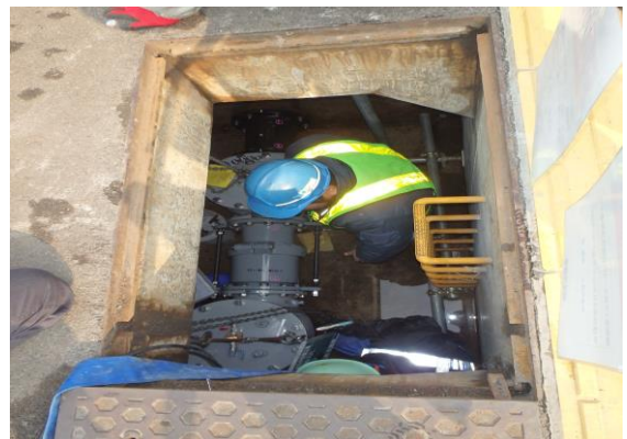
【権常寺1丁目6-3付近減圧弁設置工事】
