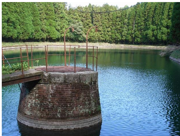
第 1 貯水池取水塔
