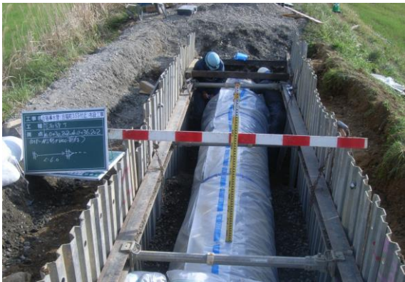
【吉福導水管布設工事】
