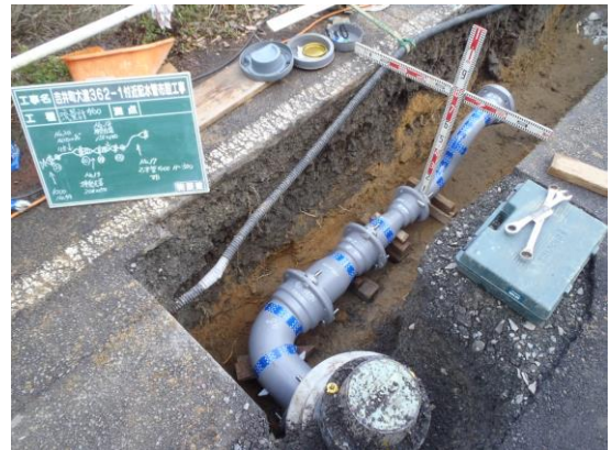
【吉井町配水管布設工事】
