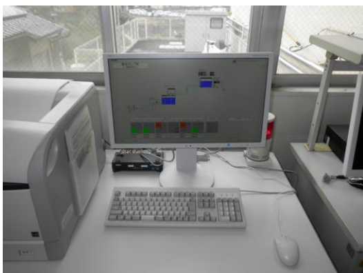
【北部地区遠方監視装置整備（その5）工事】
