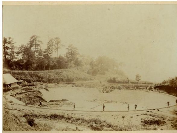
第 2 貯水池建設の様子(明治 33 年ごろ)
