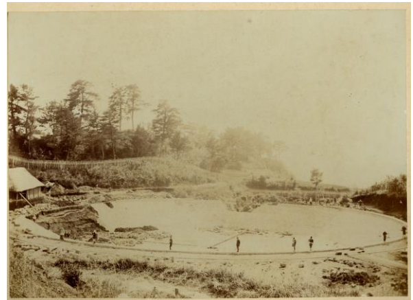
第2貯水池建設の様子(明治33年ごろ)
