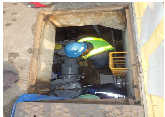
【峰ポンプ所(ポンプ・電気設備)更新工事】
