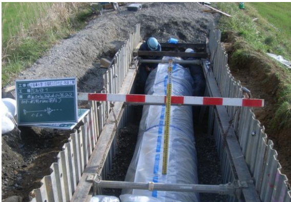
【吉福導水管布設工事】
