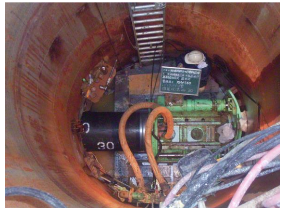
【推進工法による工事】
