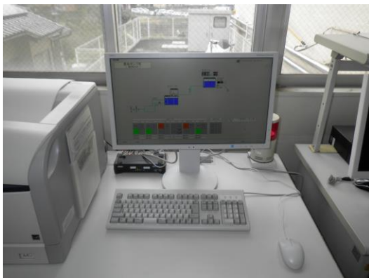
【北部地区遠方監視装置整備（その6）工事】
