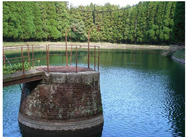
第1貯水池取水塔
