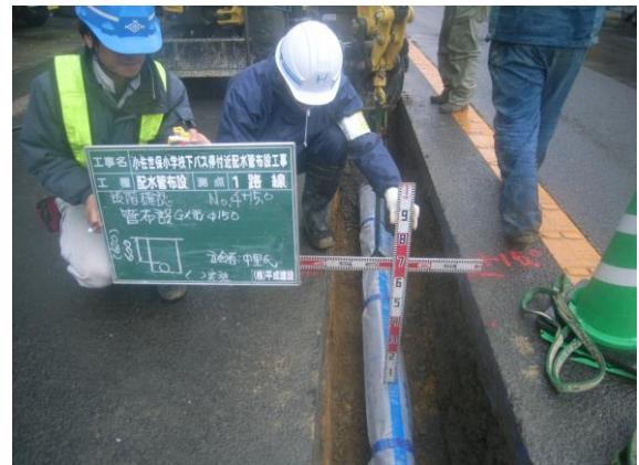
【小佐世保町配水管布設工事】
