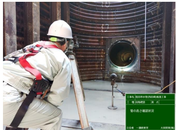
【菰田導水管（西田橋）推進工事】
