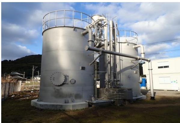
【鹿町町北部浄水場急速ろ過機更新工事】
