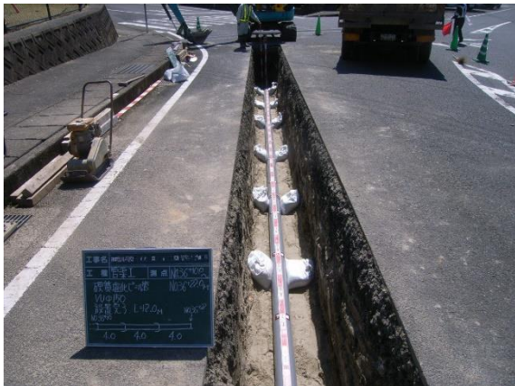
【開削工法による工事】
