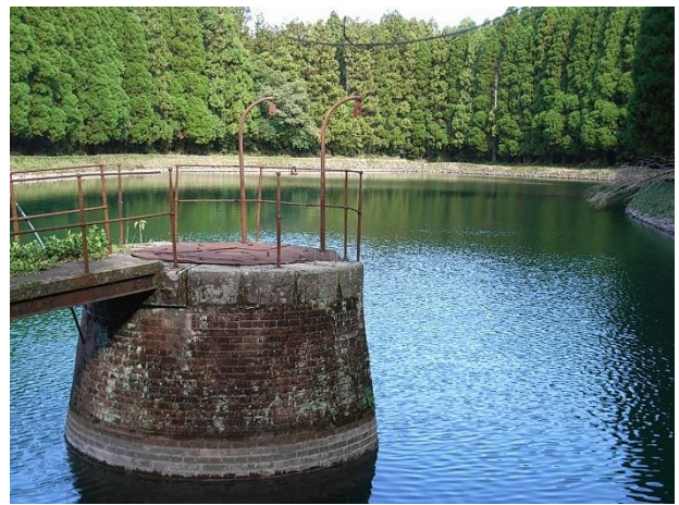
第1貯水池取水塔
