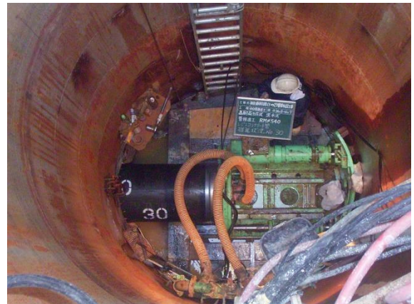
【推進工法による工事】
