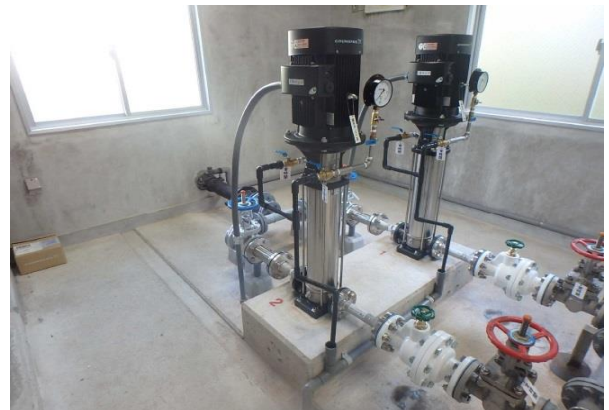
【高花ポンプ所設備更新工事】
