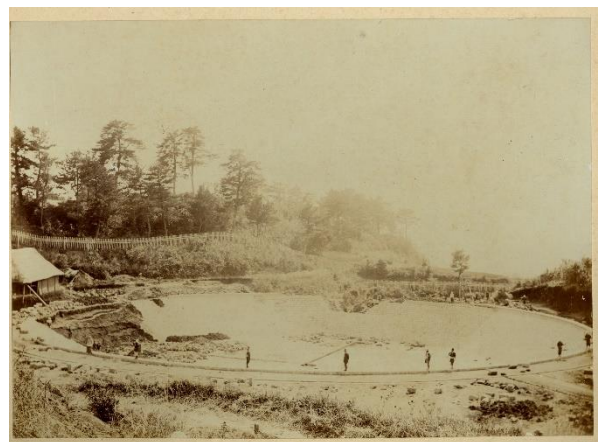
第2貯水池建設の様子(明治33年ごろ)
