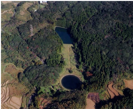
岡本水源地全景
