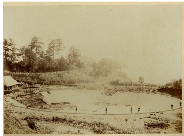
第2貯水池建設の様子(明治33年ごろ)
