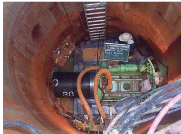
【推進工法による工事】
