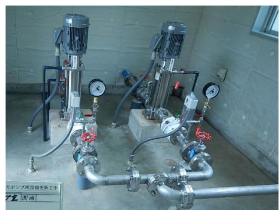
【指方ポンプ所設備更新工事】
