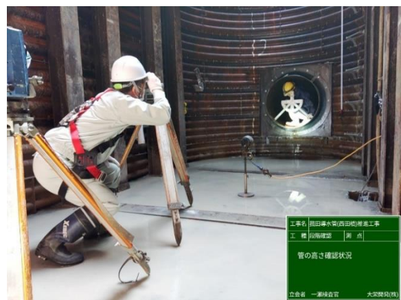
【菰田導水管（西田橋）推進工事】
