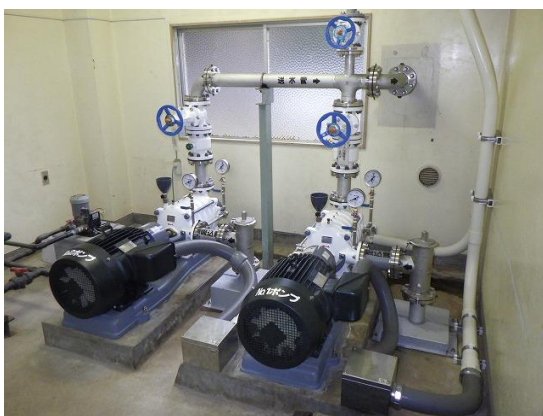
【歌ヶ浦浄水場設備機器更新工事】
