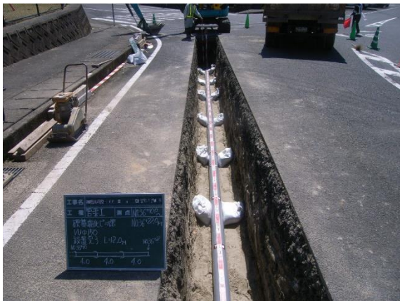
【開削工法による工事】
