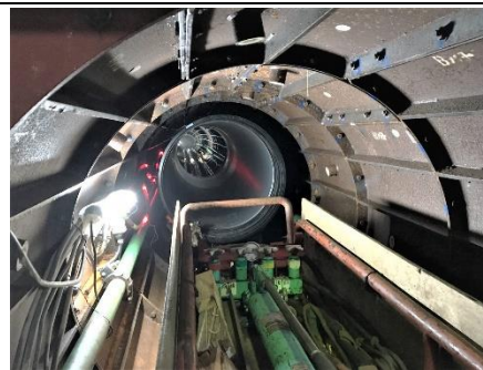
【配管が完了した坑内】
