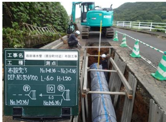
【菰田導水管（原分町付近）推進工事】
