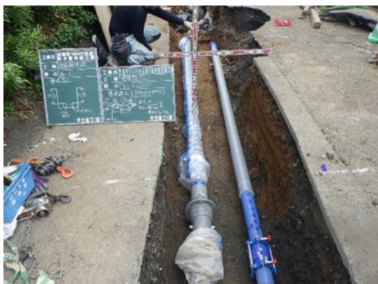
【松瀬町 1354 付近送・配水管布設工事】
