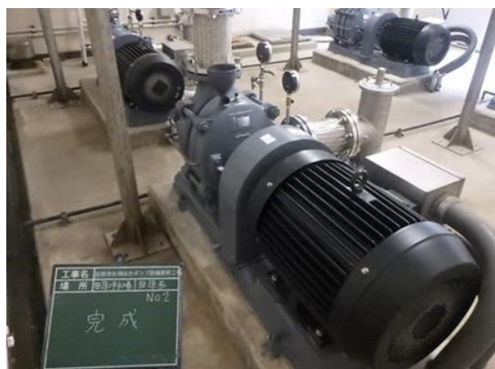
【田原浄水場ほかポンプ設備更新工事】
