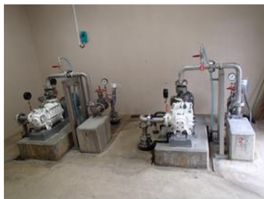
【ひかりの国地ポンプ所設備更新工事】
