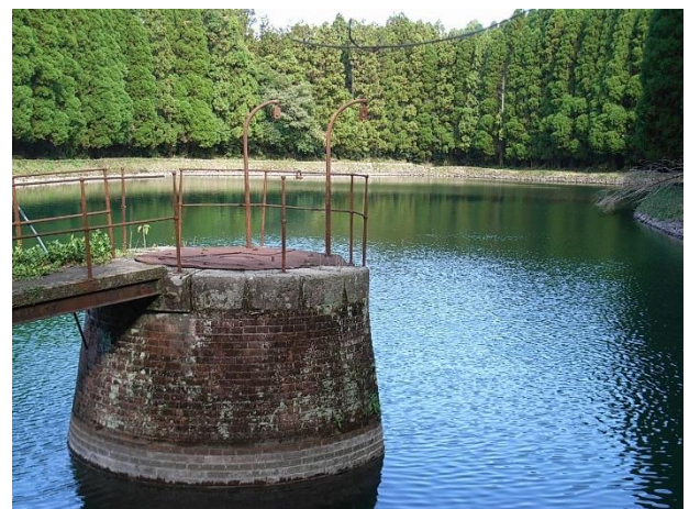
第1貯水池取水塔
