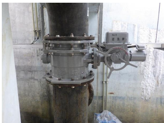
【広田浄水場6号ろ過池電動弁更新工事】
