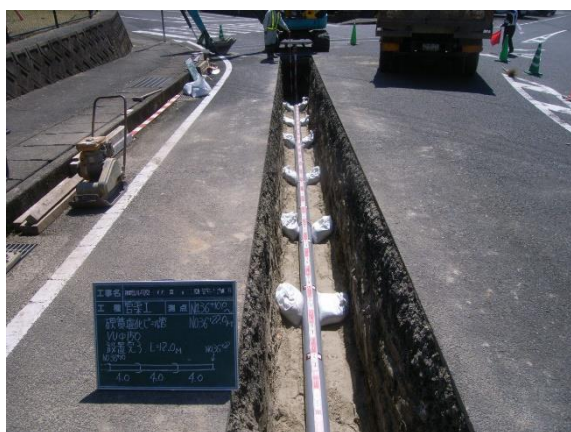
【開削工法による工事】
