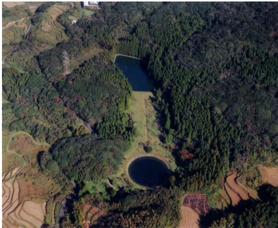
岡本水源地全景
