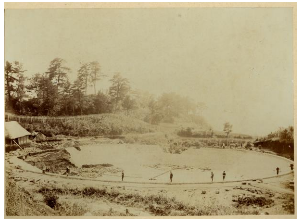
第2貯水池建設の様子(明治33年ごろ)
