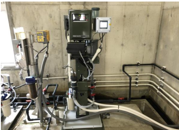
【田原浄水場原水濁度計・pH計更新工事】
