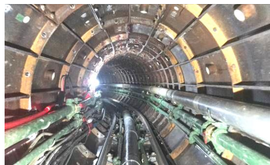
【一次覆工が完了した坑内】
