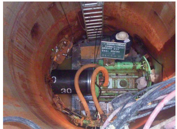
【推進工法による工事】
