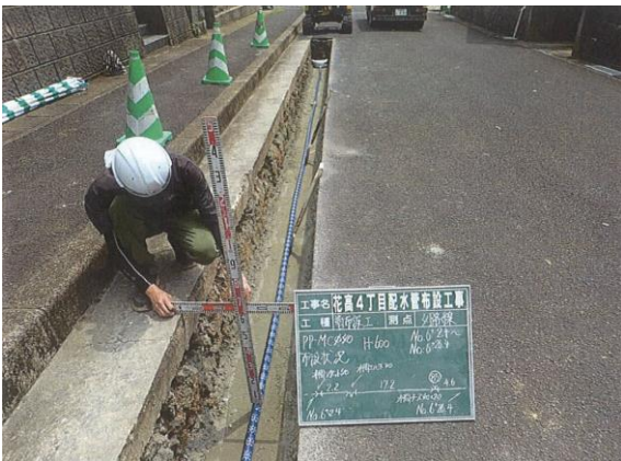
【花高4丁目配水管布設工事】
