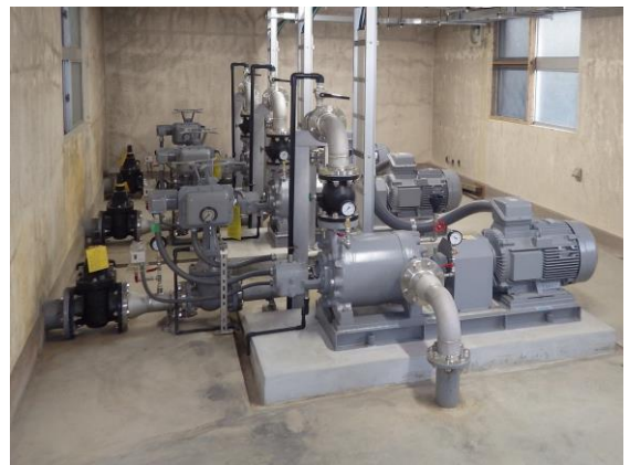
【東山手ポンプ所設備更新工事】
