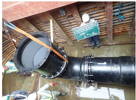
【菰田導水管（地蔵川）推進工事】
