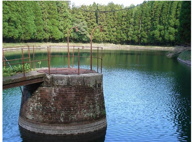
第1貯水池取水塔
