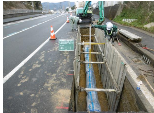
【崎岡町3151付近配水布設工事】
