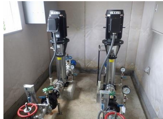
【柚木元町第一ポンプ所更新工事】
