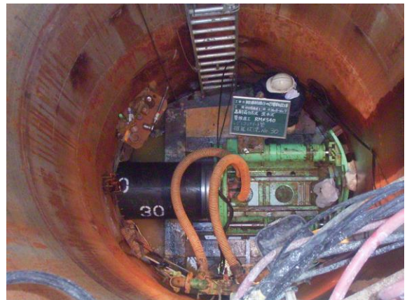
【推進工法による工事】
