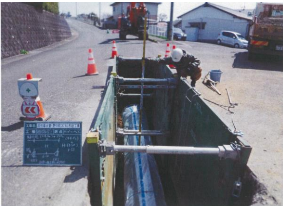
【菰田導水管（野中町376付近）布設工事】
