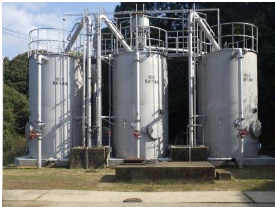
【江迎浄水場ろ過機更新工事】
