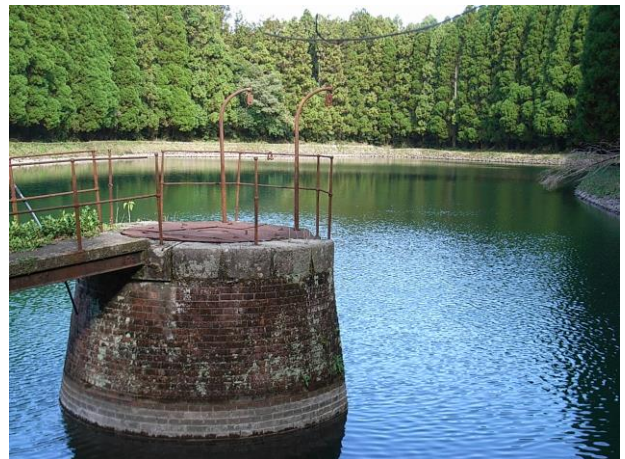
第 1 貯水池取水塔
