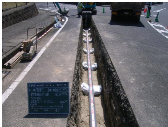
【開削工法による工事】
