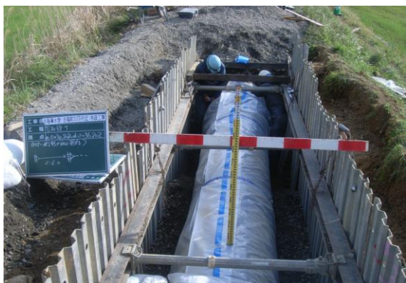
【吉福導水管布設工事】
