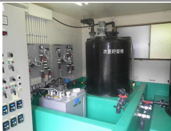
【江迎浄水場薬品注入施設整備工事】
