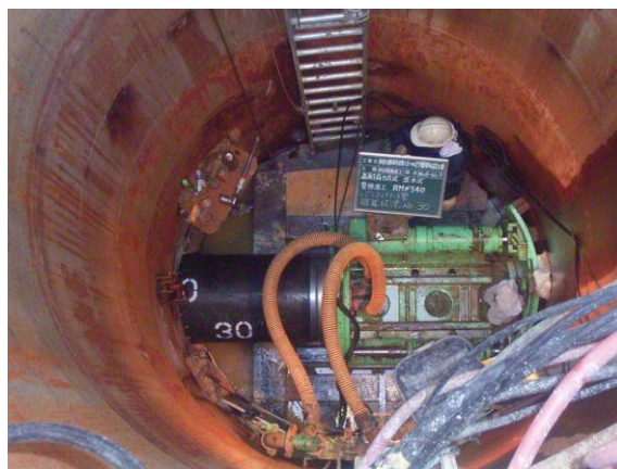
【推進工法による工事】
