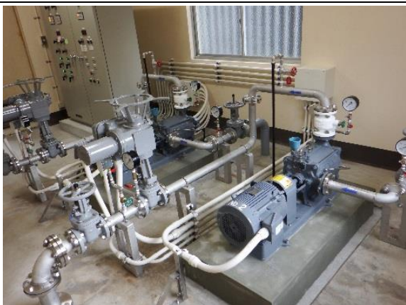
【棚方ポンプ所（電気・ポンプ設備）更新工事】
