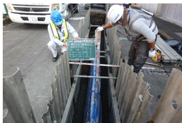
【宮田町周辺配水本管布設工事】
