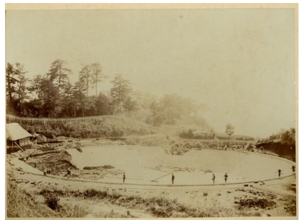
第 2 貯水池建設の様子（明治 33 年ごろ）
