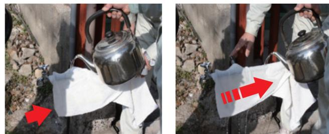
急激に温めると破裂する恐れがあるので、熱湯はかけないでね！！
