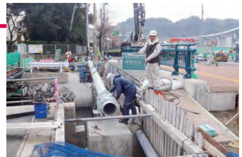
【新しい水道管への取り替え工事】
