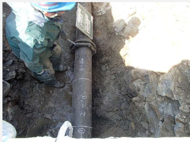
管路健全度評価調査(肉厚測定)
