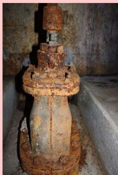
ダム取水施設
