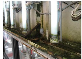
↑内照式看板内部の腐食、部材の腐食器具の劣化による出火の恐れも。
