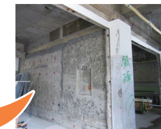
壁と柱を残している状態
